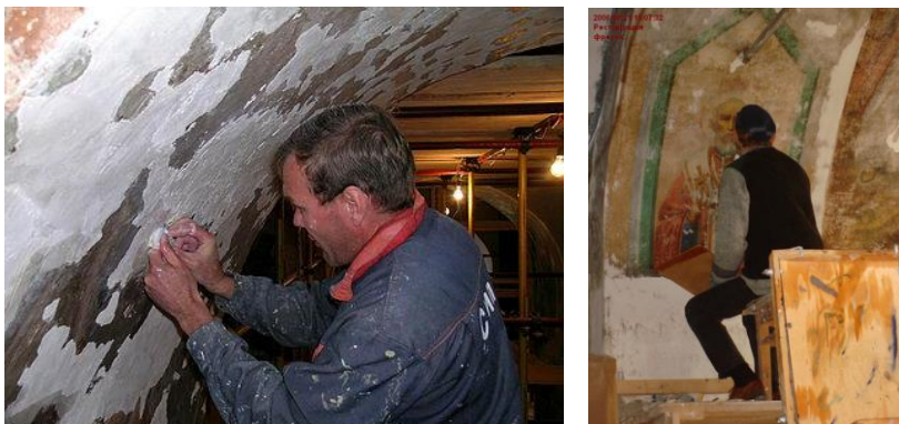
Рисунок 267 – Восстановление красочных поверхностей
