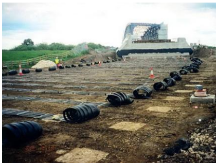
Рисунок 293 – Устройство георешетки на просадочных грунтах
