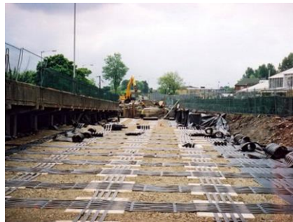
Рисунок 293 – Устройство георешетки на просадочных грунтах
