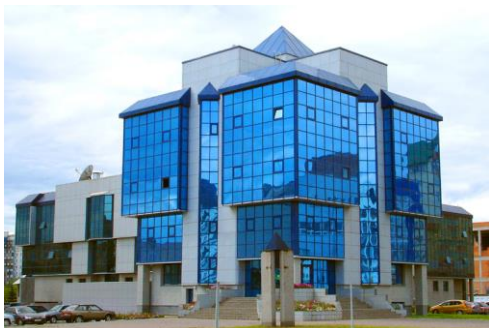
Рисунок 138 – Здание центрального отделения Сбербанка в г. Новокузнецке
