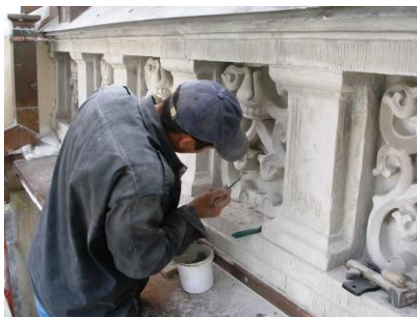
Рисунок 269 – Восстановление каменной резьбы
