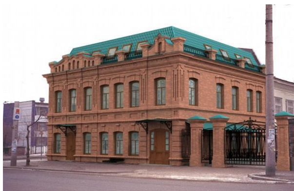
Рисунок 243 – Устройство мансарды с окнами в плоскости крыши над старинным особняком
