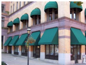
Рисунок 288 – Устройство козырьков над окнами
