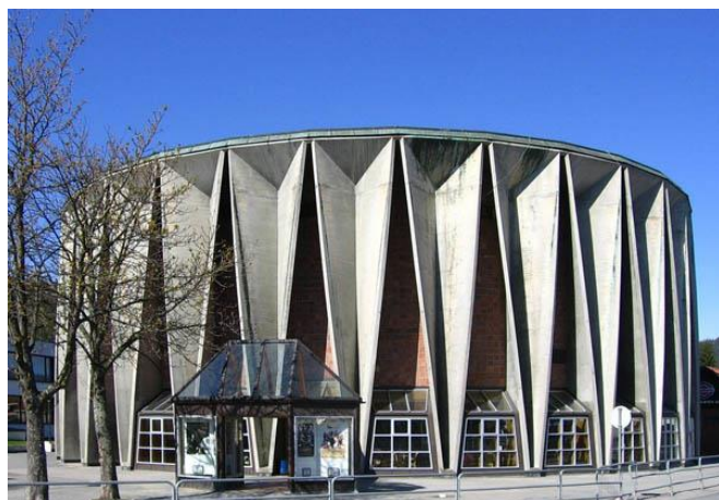
Рисунок 176 – Рельефная поверхность фасада здания кинотеатра в Норвегии
