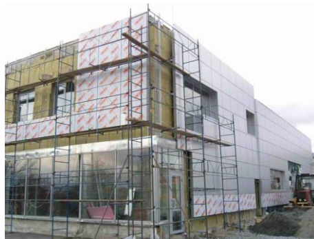
Рисунок 254 – Реконструкция фасада с утеплением и обшивкой сайдингом
