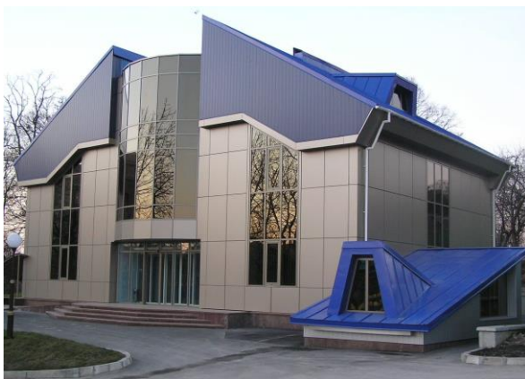
Рисунок 255 – Реконструкция загородного дома с обновлением фасада
