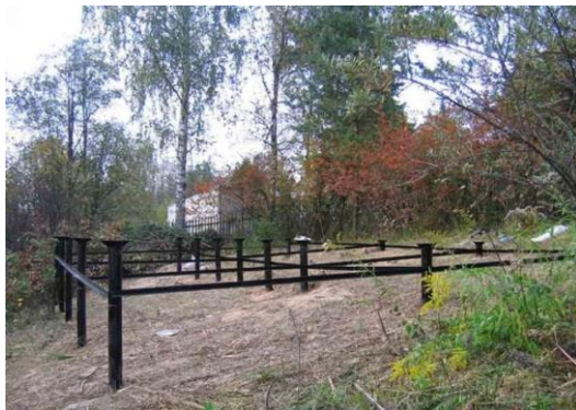
Рисунок 294 – Устройство фундаментов на просадочных грунтах
